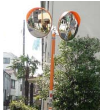
▲カーブミラーの設置(上高田5丁目)
