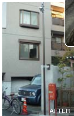
◀腐食した街路灯の交換 (新井5丁目)
